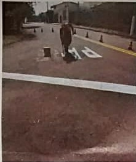
Pinturas das Faixas de Trânsito das Ruas
